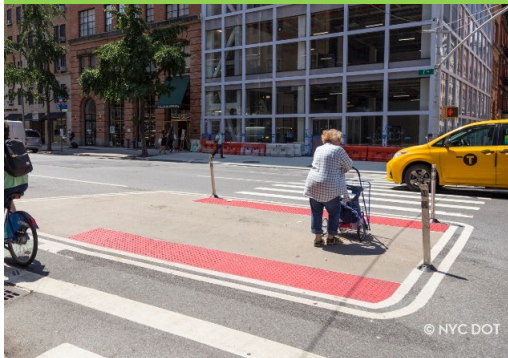
Islas de refugio peatonal
