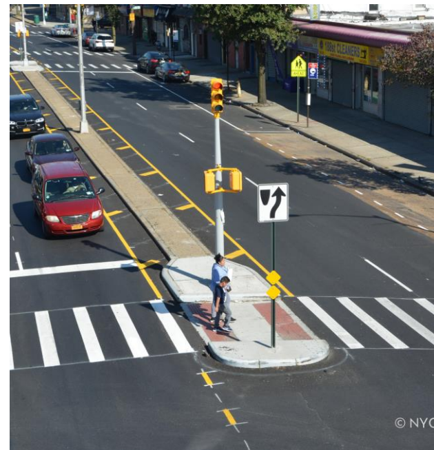
Расширение окончания разделительной полосы, Jamaica, Queens
