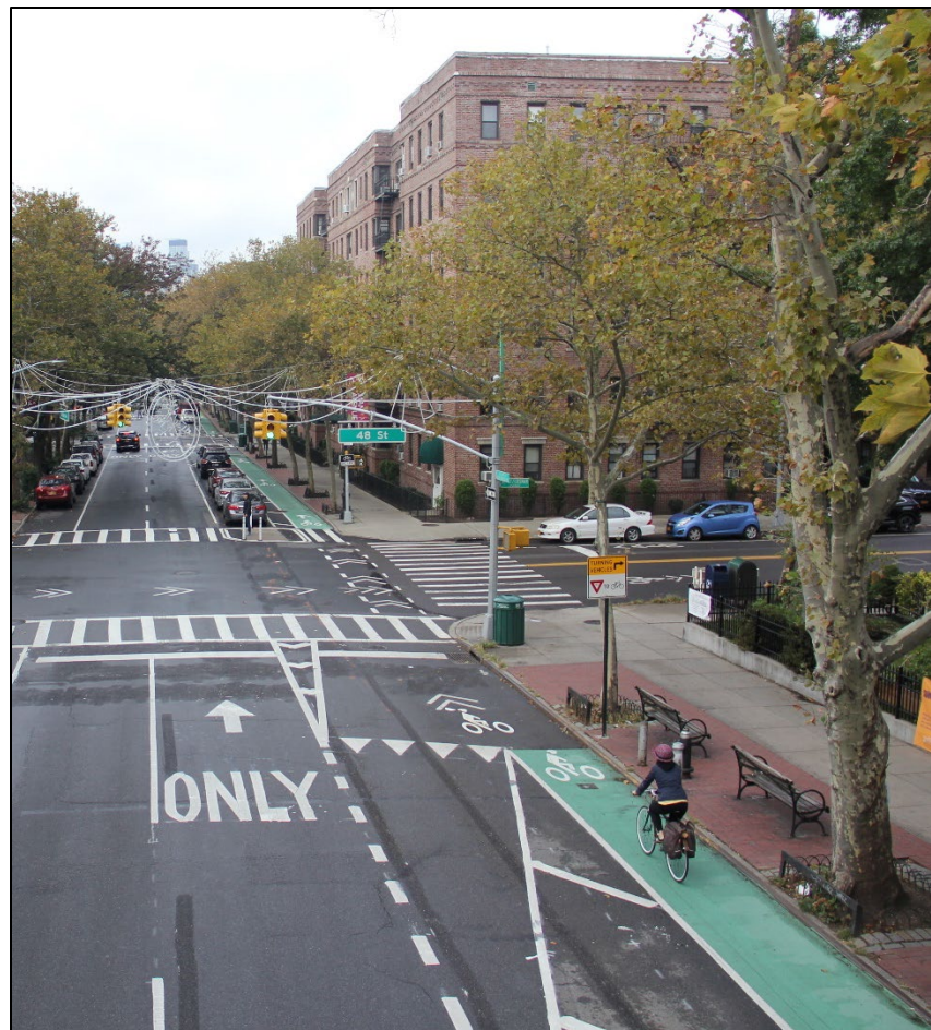
Carril protegido para bicicletas: Skillman Ave, QN.
