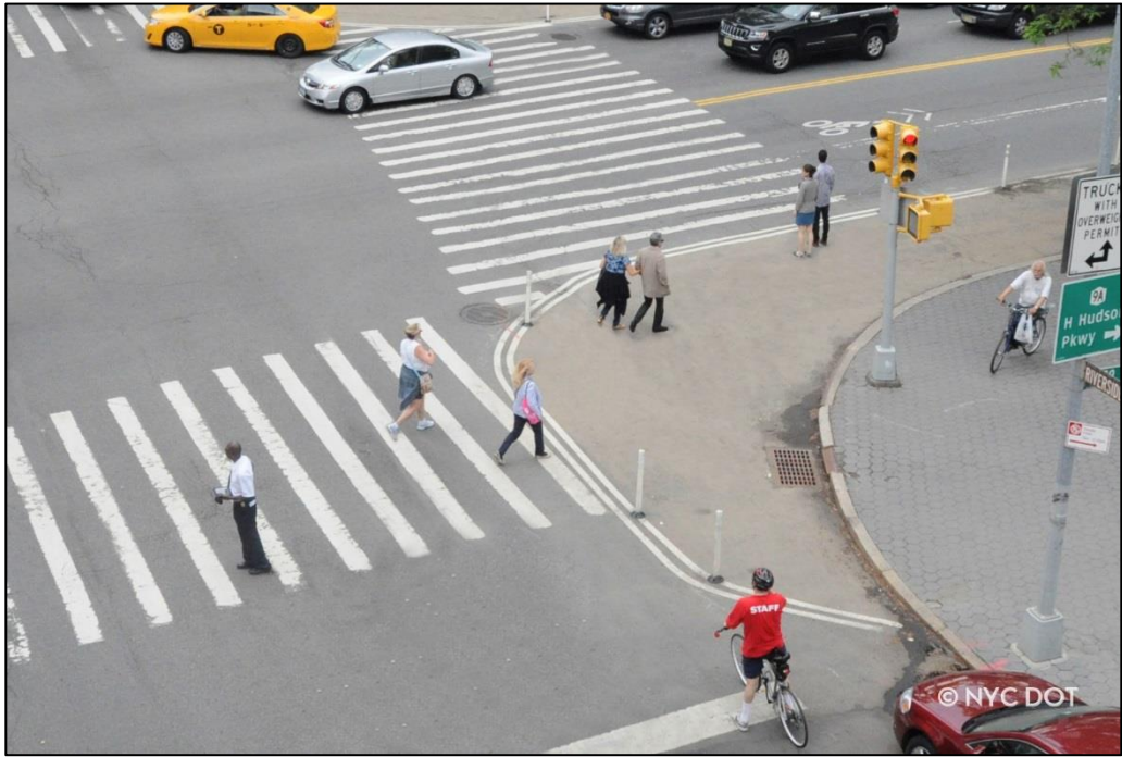
噴漆路緣延伸區
