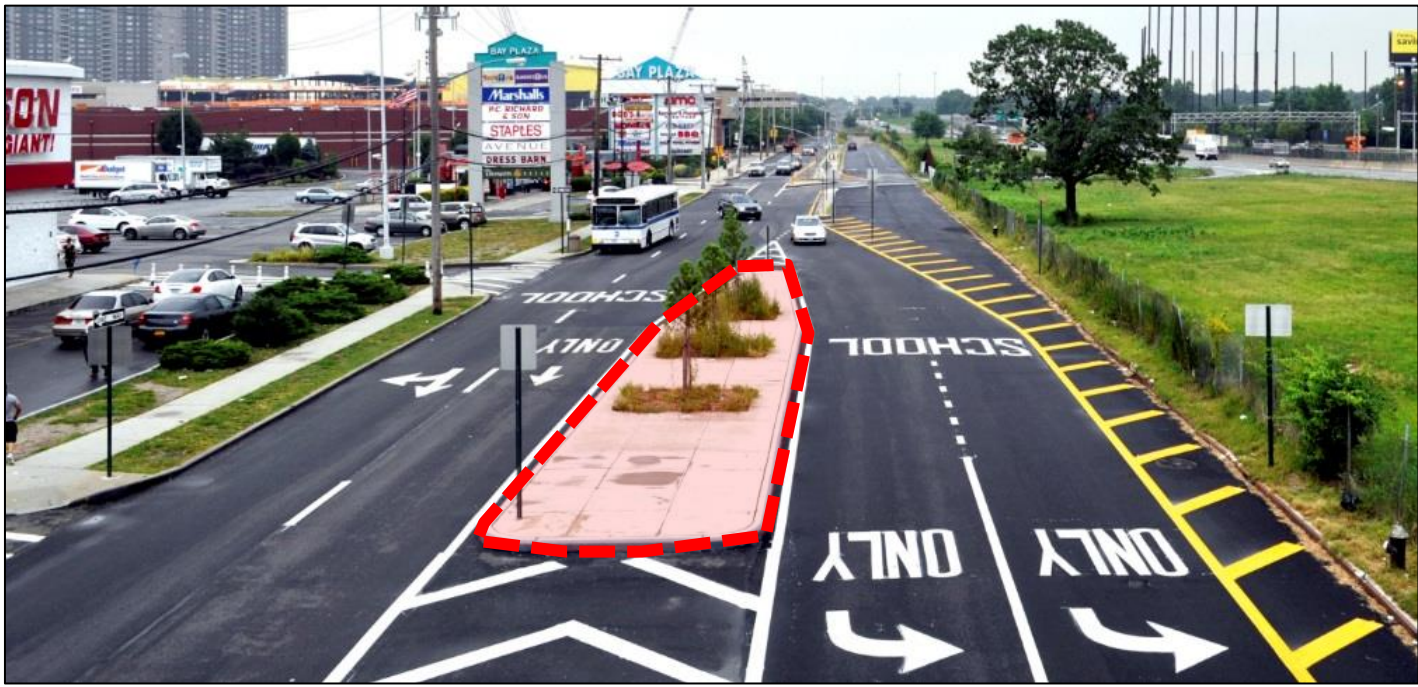
混凝土等待區
