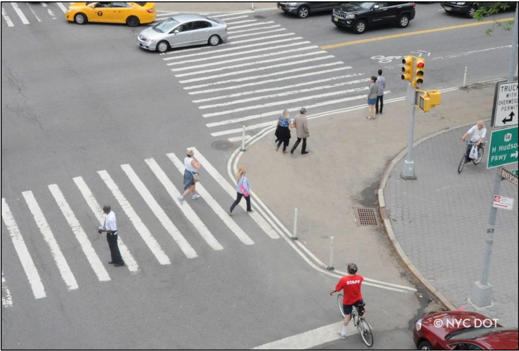
喷漆路缘延伸区
