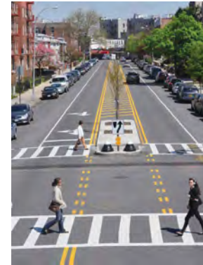
Medidas para calmar el tráfico: Después (eliminación de carril)
