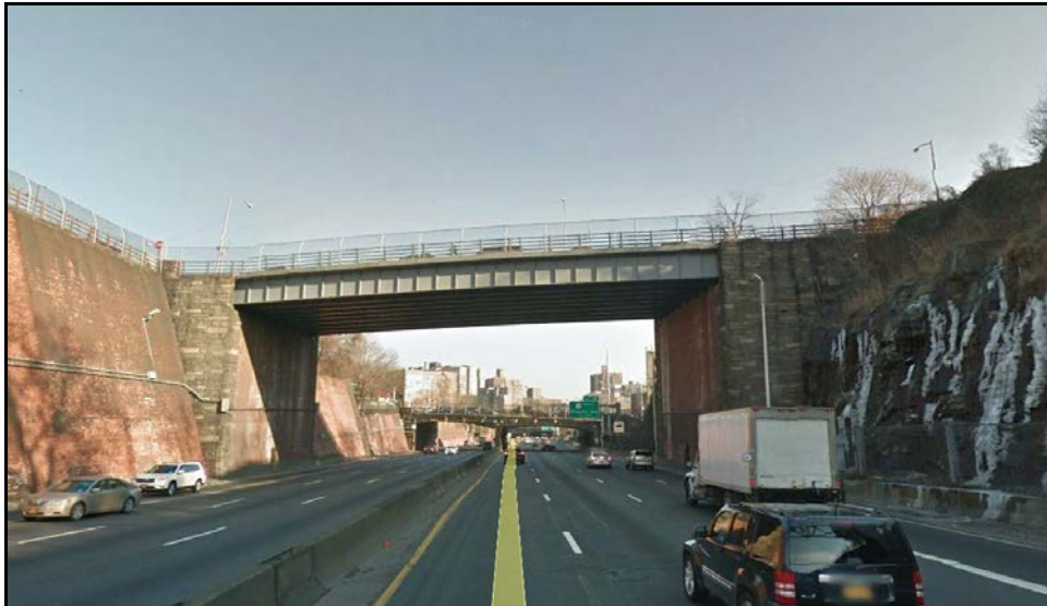
13) Jesup Avenue Bridge
