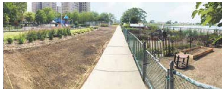
El canal de filtro biológico de Workshop Garden y un nuevo prado en construcción.
