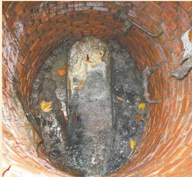
Se demuestra la acumulación de grasa en la alcantarilla que sirve a 70-72 Baruch Drive en el residencial Baruch Houses.
