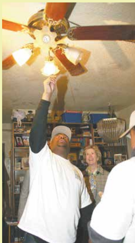
Un empleado de NYCHA instala gratuitamente una lámpara fluorescente compacta (CFL, por sus siglas en inglés) en el Residencial Queensbridge Houses.
