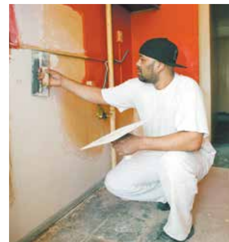
Un trabajador de mantenimiento de NYCHA enyesa una pared en el Residencial Marble Hill Houses.
