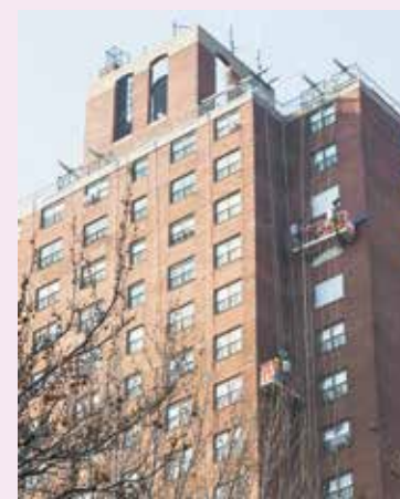
Equipos de trabajo hacen reparaciones al exterior de un edificio en el residencial Kingsborough Houses en Brooklyn.
