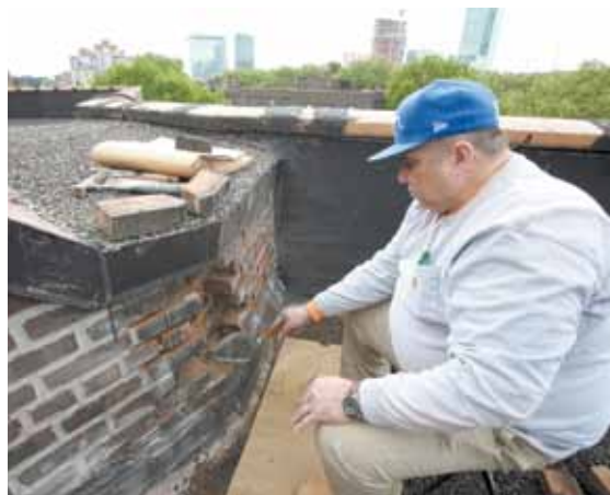
Parte de los proyectos de reparación de capital incluyen trabajo de mampostería y techos.
