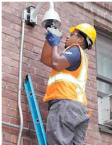
La instalación de un nuevo sistema de seguridad en el residencial Amsterdam Houses.
