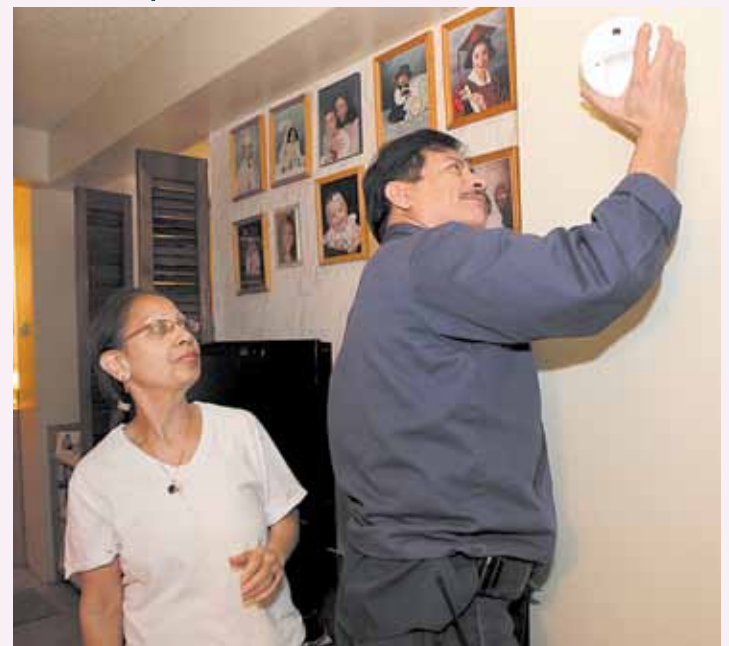
El 25 de abril de 2012, Elizabeth Crespo, residente del residencial Queensbridge South, observa al empleado de mantenimiento de NYCHA, Roberto Balina, que instala una alarma de monóxido de carbono nueva en su apartamento.
