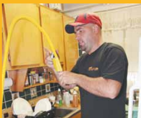
El plomero de NYCHA, Mike Reed, verifica una cocina como parte de la respuesta de NYCHA a la gran interrupción de gas en el norte de Manhattan en agosto de 2011.
