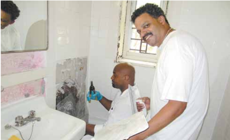
Los miembros del equipo de trabajo de NYCHA arreglan un baño en South Jamaica Houses en Queens el 9 de agosto de 2011.
