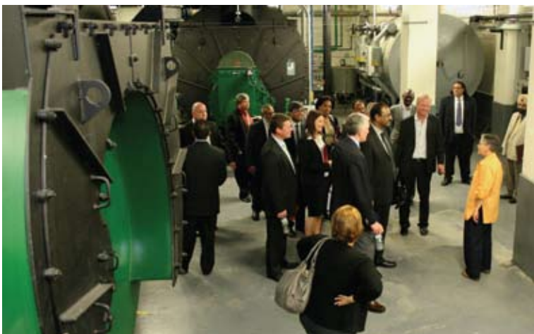
Varios ejecutivos de NYCHA les demuestran a una delegación sudafricana las nuevas calderas, eficientes con el uso de energía, en el residencial Castle Hill Houses en El Bronx.
