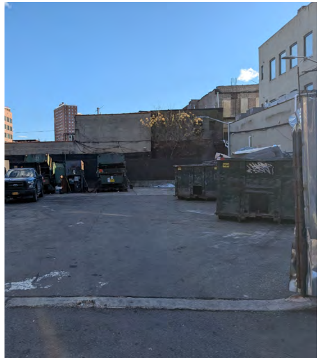
EXISTING WASTEYARD PATIO DE BASURA EXISTENTE
