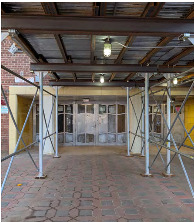
EXISTING BUILDING ENTRY ENTRADA AL EDIFICIO EXISTENTE
