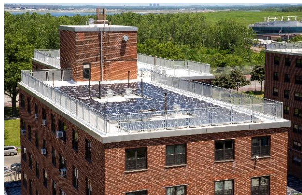
在 Ocean Bay (Bayside) 的屋顶和太阳能电池板系统维修
