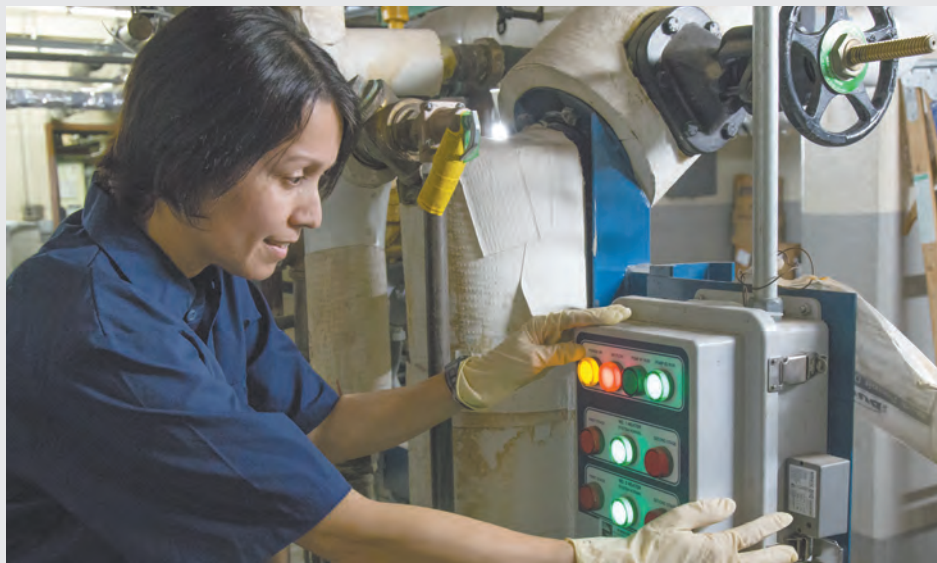
Lillian Hernandez, técnica de planta de calefacción, realiza pruebas de seguridad a las calderas en Whitman Houses para asegurarse de que estén funcionando adecuadamente para que los residentes tengan agua caliente y calefacción cuando haga frío.
