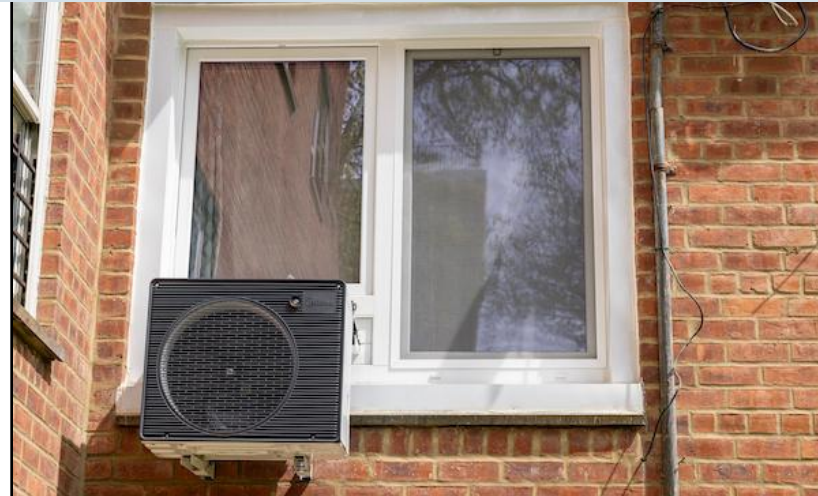
Woodside: Instalación de bombas de calor del programa piloto «Calor limpio para todos»
