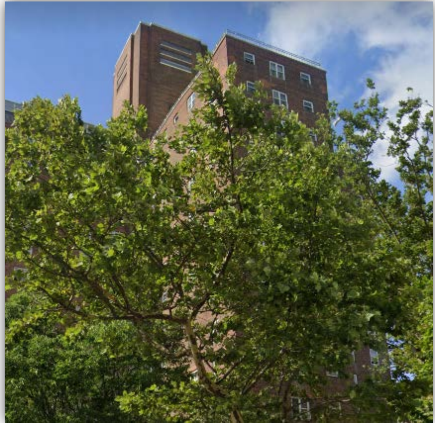
466 East 10 th Street– Edificio 11
