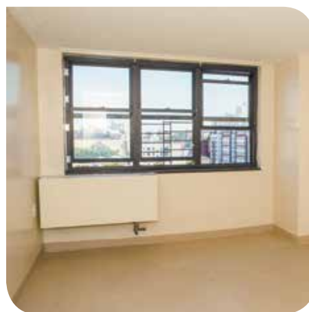
Ahora todos los apartamentos tienen nuevas ventanas y mosquiteros, además de unidades de aire acondicionado y calefacción que los inquilinos pueden controlar por sí mismos.
