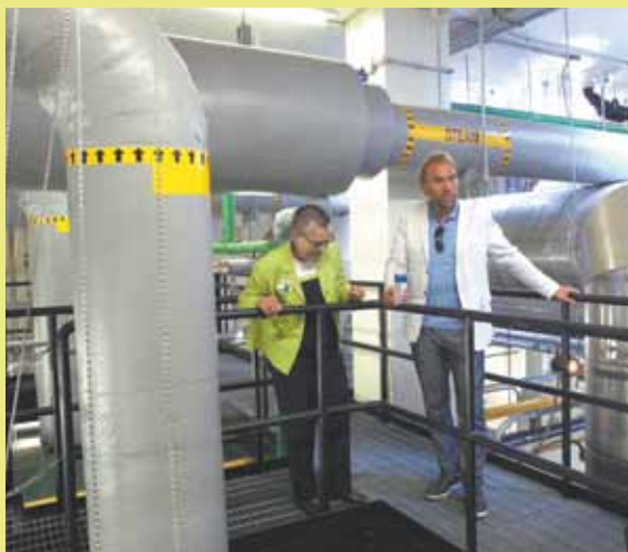
La Comisionada de NYCHA Margarita López le muestra a Johan Ernst Nilson, conocido como 'Johan el Explorador', la planta de la caldera central de Castle Hill Houses en el Bronx. El Sr. Nilson está viajando del Polo Norte al Polo Sur para generar una mayor conciencia sobre la sustentabilidad medioambiental.
