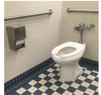
Hacer accesible una sala de aseo
