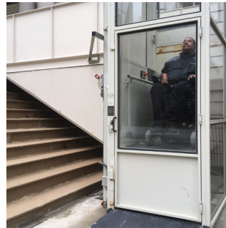
Instalación de un elevador
