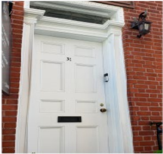
EXISTING DOOR INTERCOM NTS
