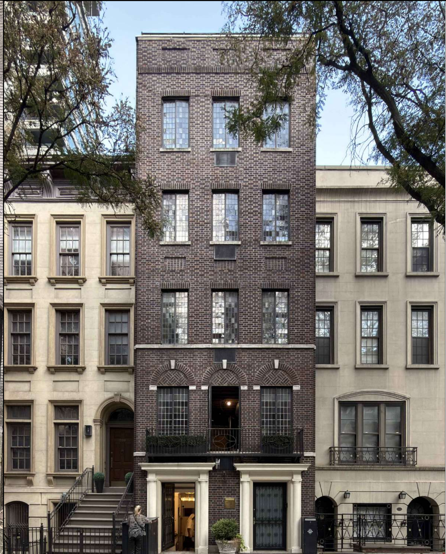
1 211E 62ND ST FACADE VIEW 1 (PROPERTY) SCALE: N.T.S.
