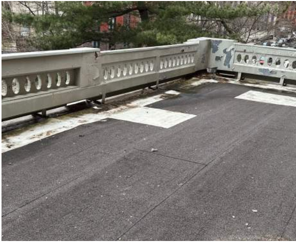
A36 - REPLACE PORTICO ROOF MEMBRANE
