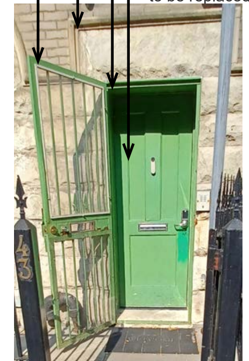
Existing Door B
