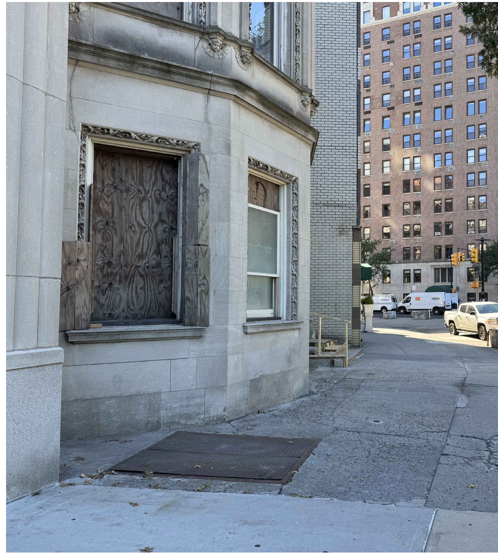
4 EXISTING METAL HATCH TO CELLAR SCALE: N.T.S.
