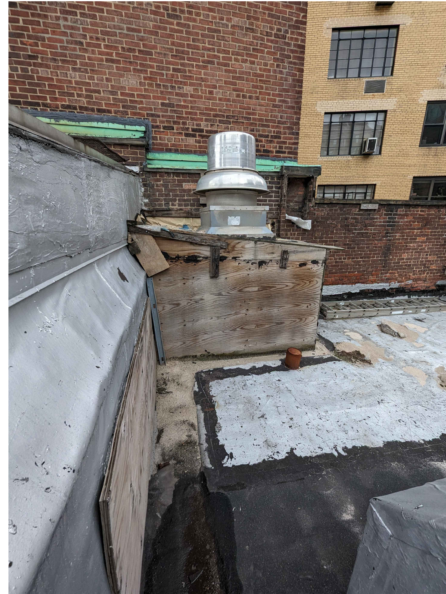
5 PHOTO OF EXISTING NORTH WALL SCALE: N.T.S.
