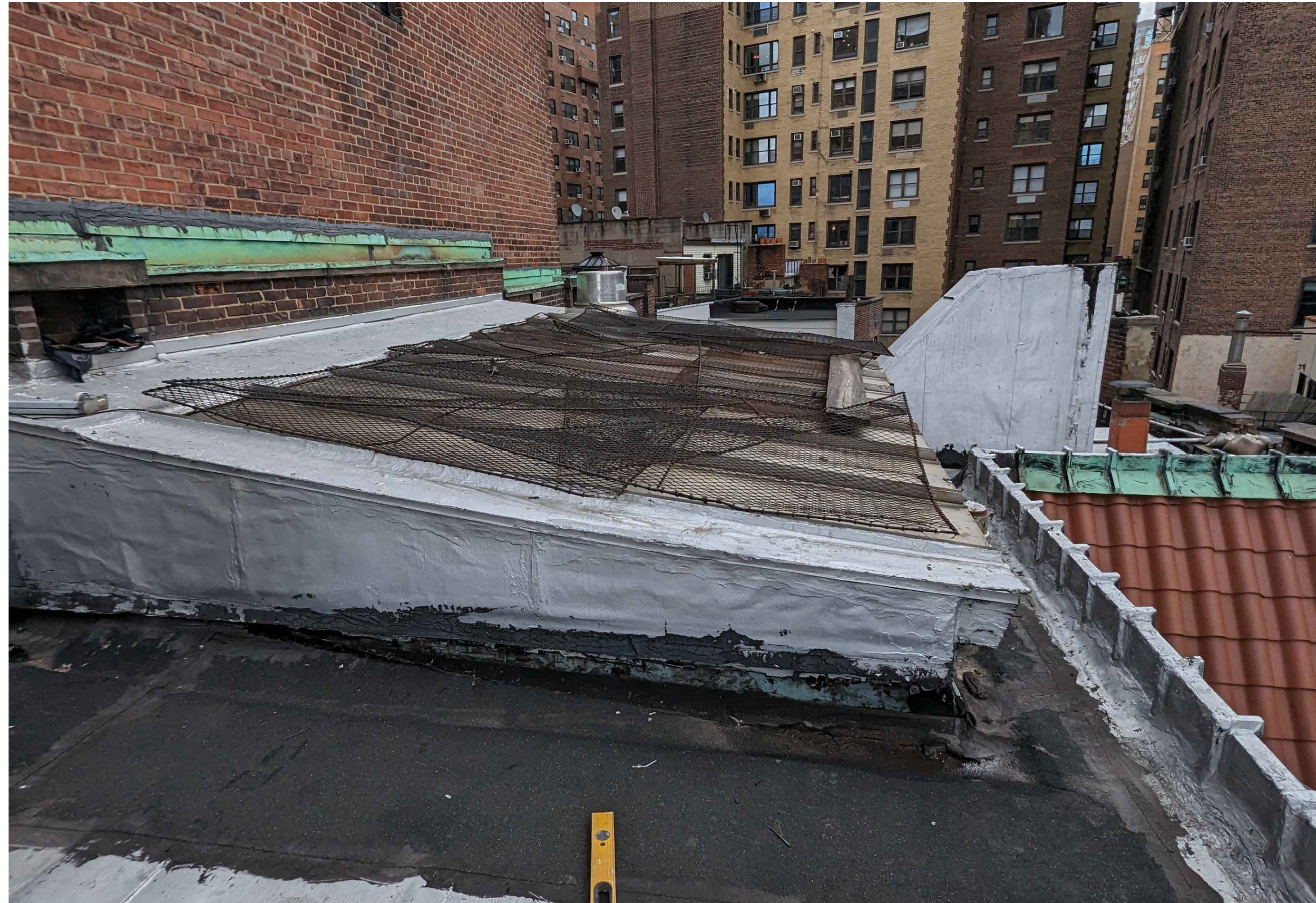
6 PHOTO OF EXISTING SKYLIGHT BULKHEAD SCALE: N.T.S.
