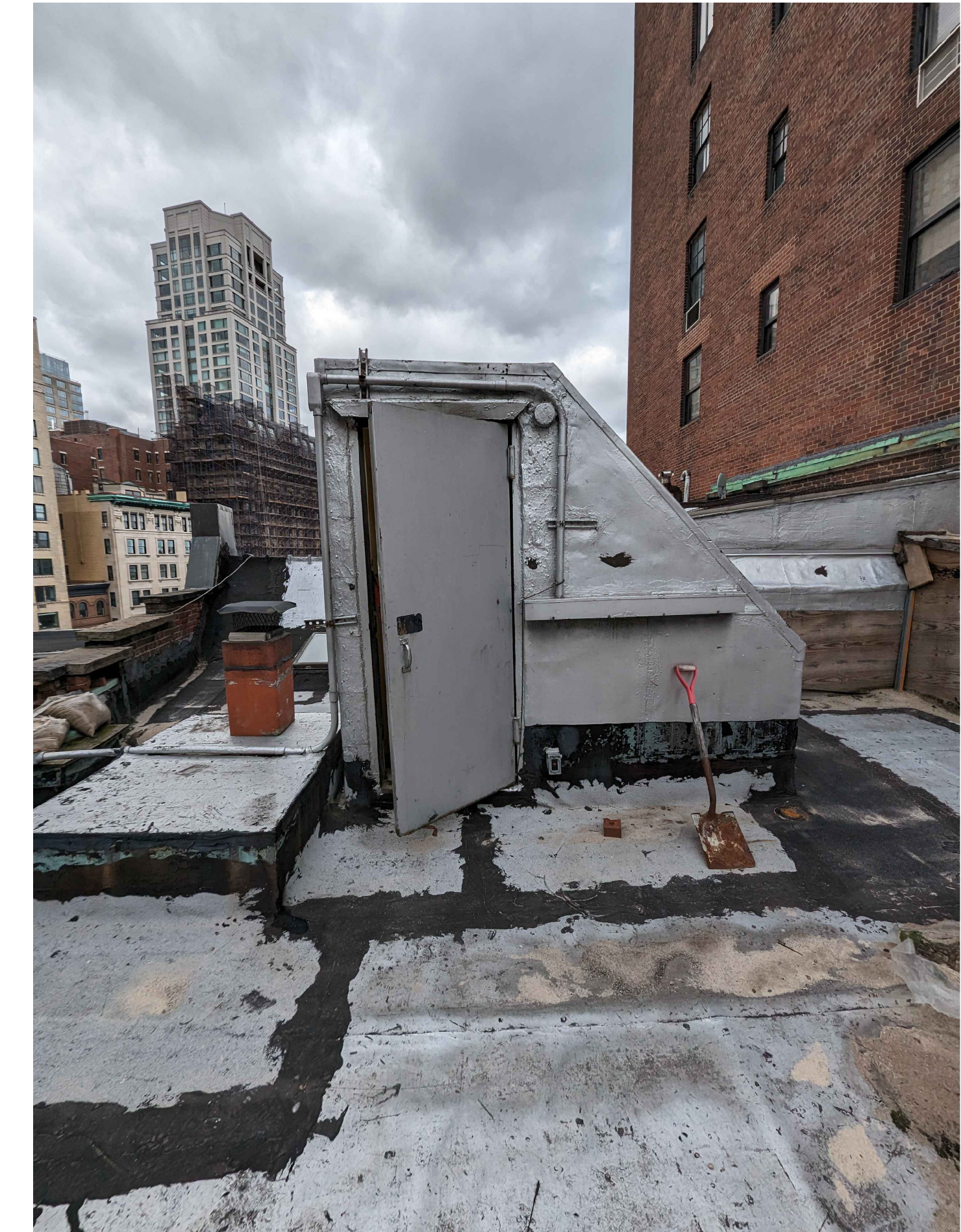
4 PHOTO OF EXISTING BULKHEAD SCALE: N.T.S.
