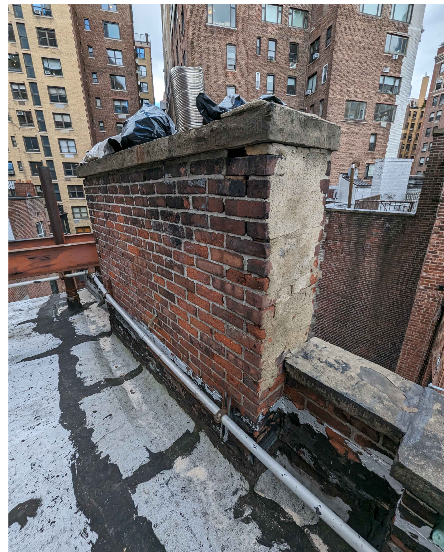
2 PHOTO OF EXISTING CHIMNEY SCALE: N.T.S.
