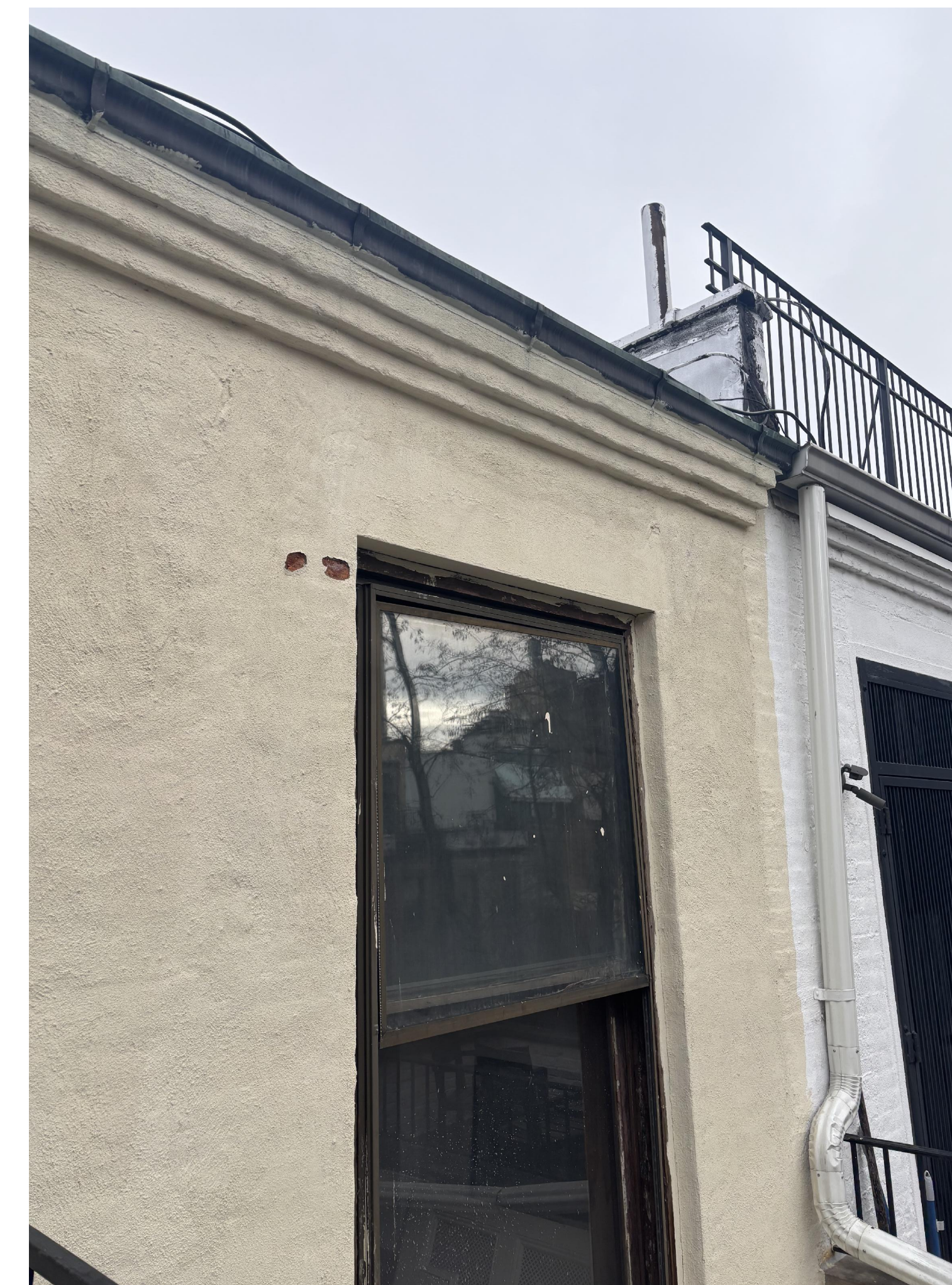
03 140W 88TH STREET - EXISTING REAR ROOF CORNICE SCALE: N.T.S.
