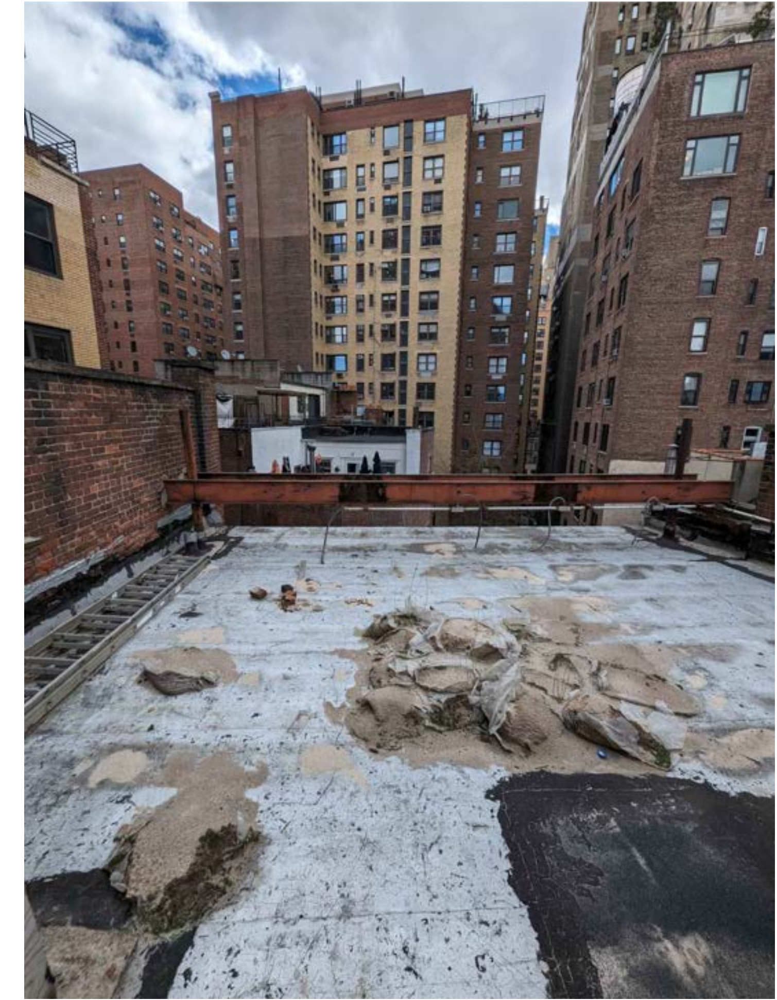
3 EXISTING CONDITION - REAR ROOF SCALE: N.T.S.
