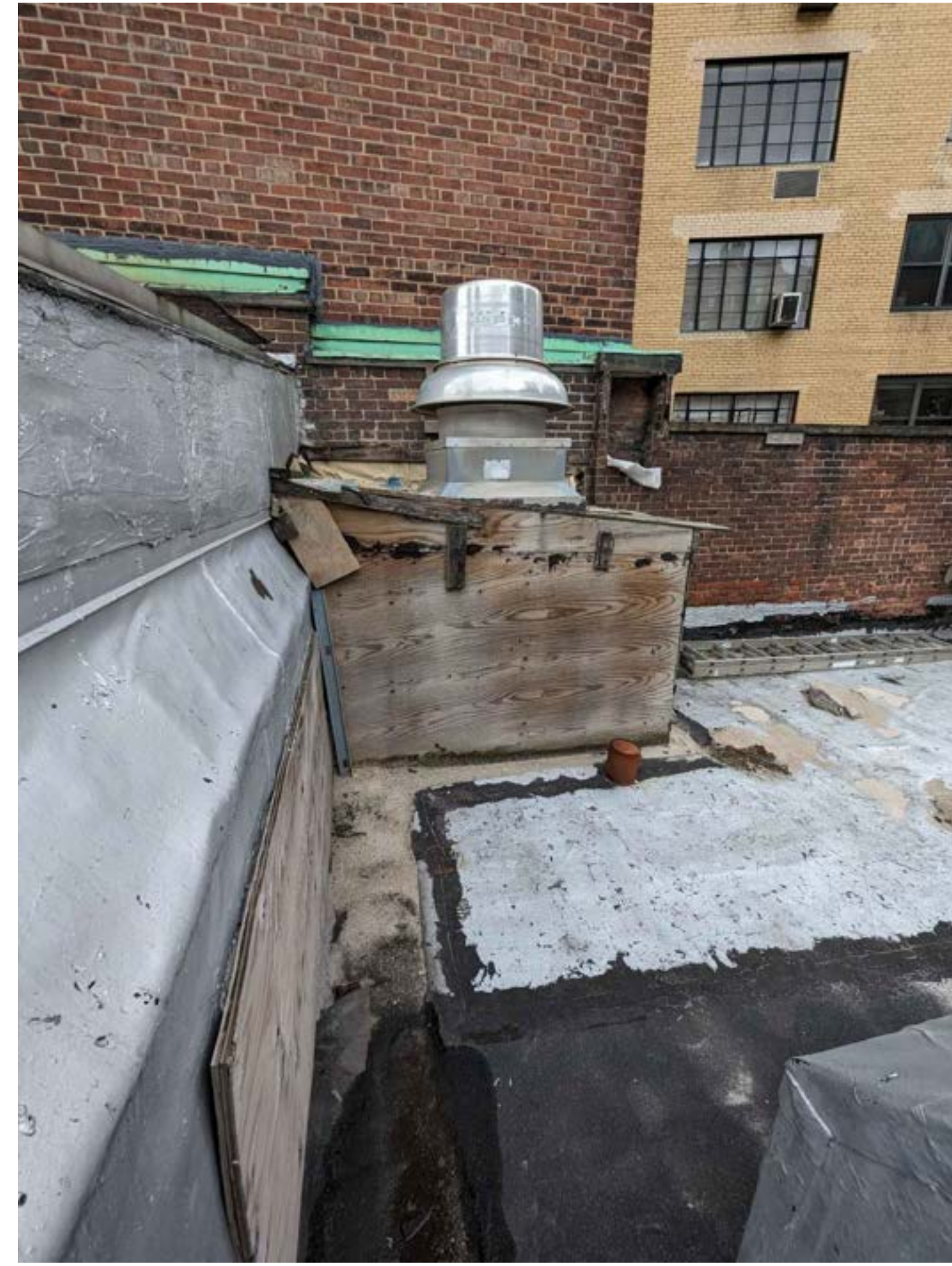
5 PHOTO OF EXISTING NORTH WALL SCALE: N.T.S.
