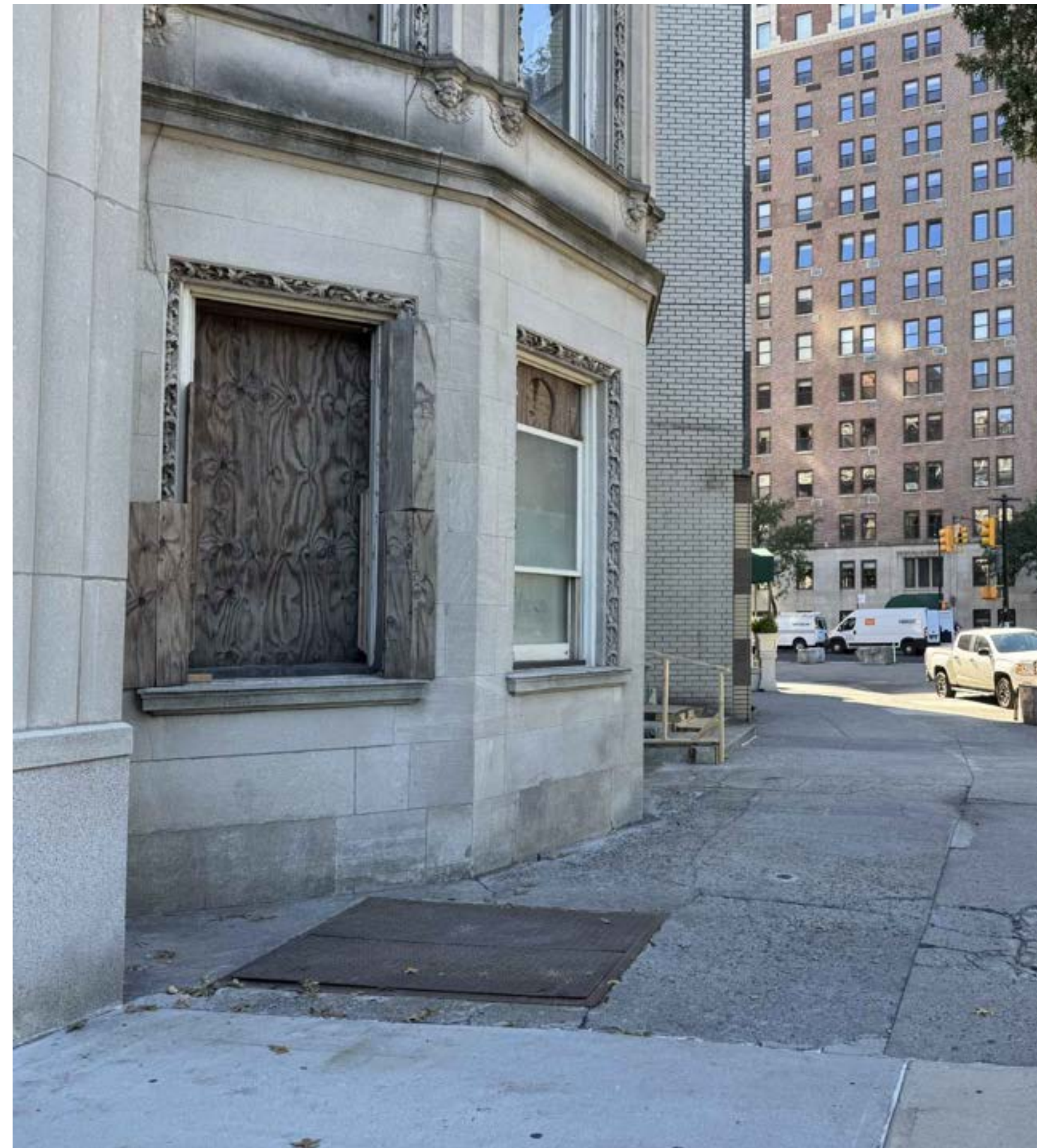
4 EXISTING METAL HATCH TO CELLAR SCALE: N.T.S.
