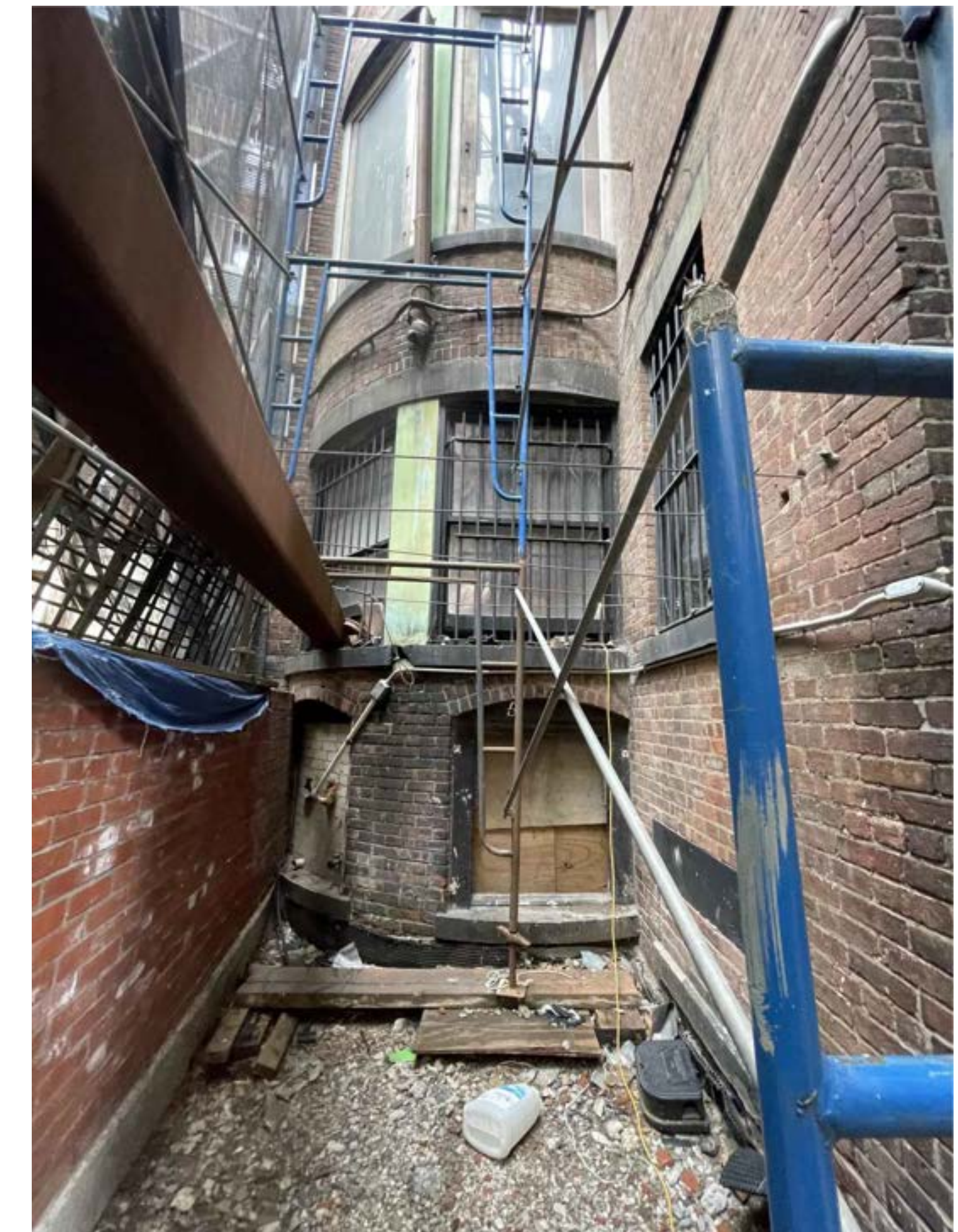
1 EXISTING CONDITION - REAR YARD SCALE: N.T.S.
