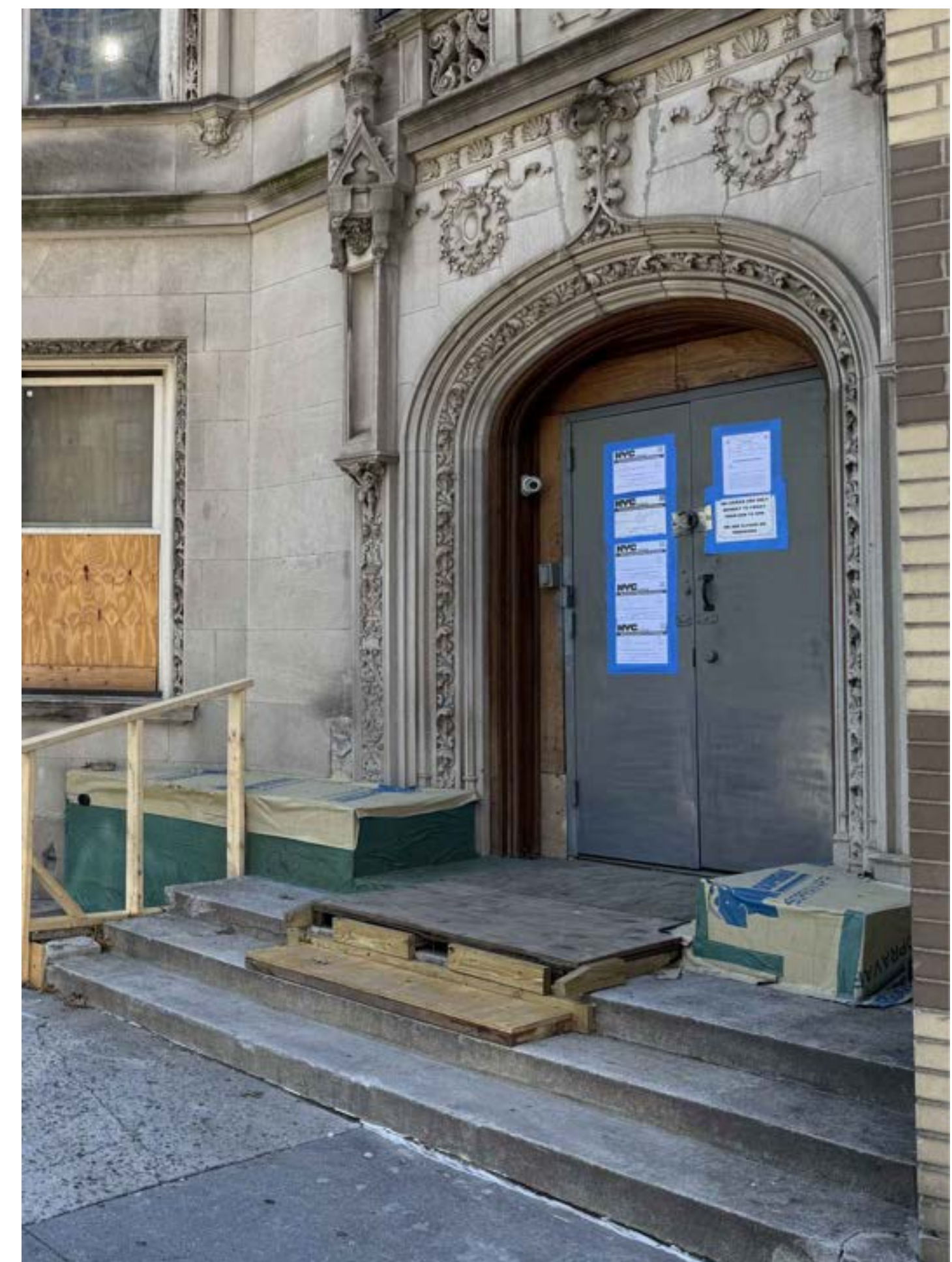
1 EXISTING CONDITION - ENTRANCE & AREAWAY SCALE: N.T.S.
