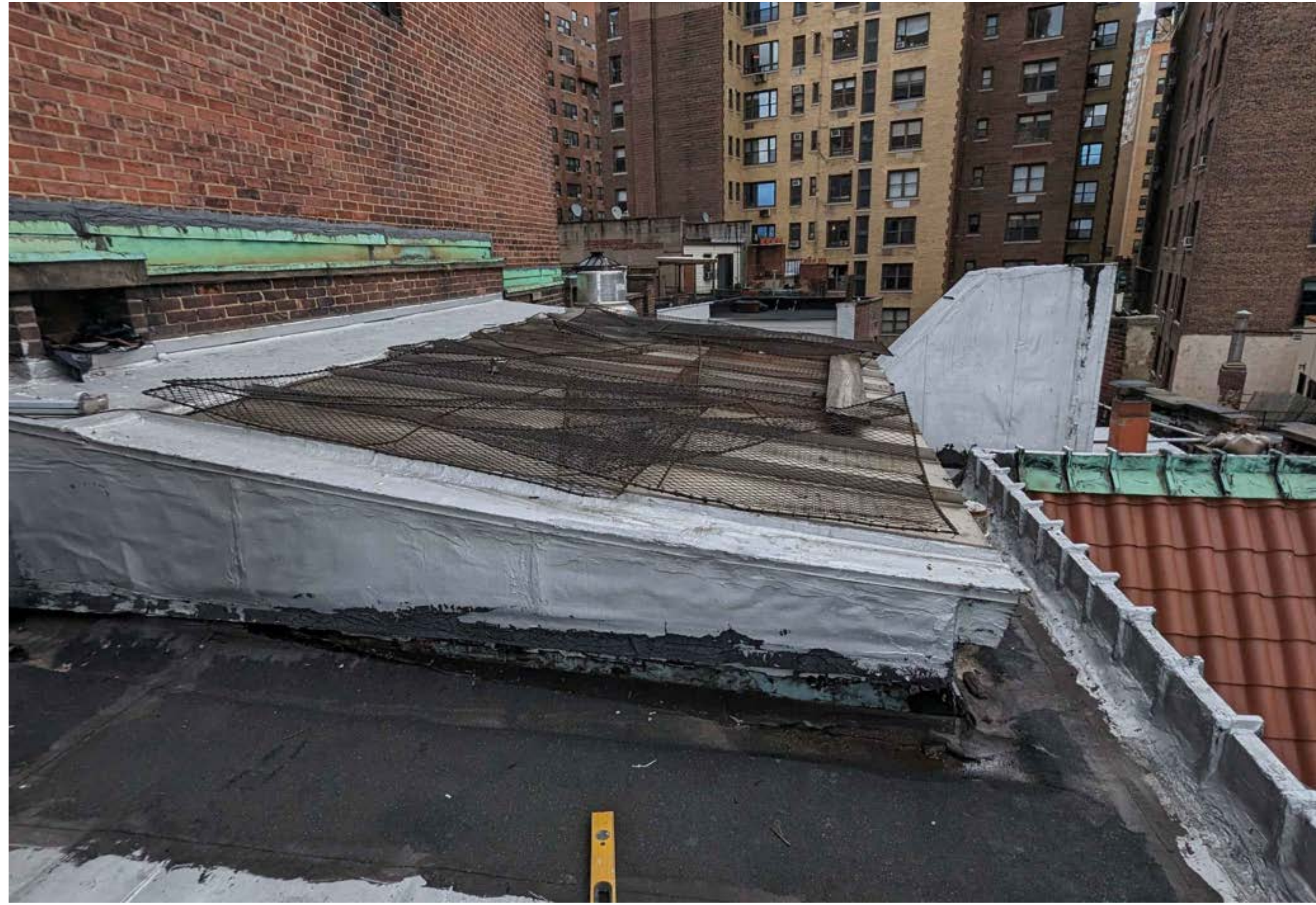
6 PHOTO OF EXISTING SKYLIGHT BULKHEAD SCALE: N.T.S.
