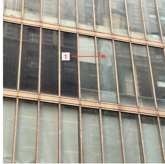
IGU failure
