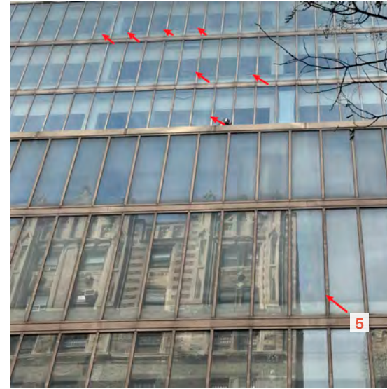
IGU failure
