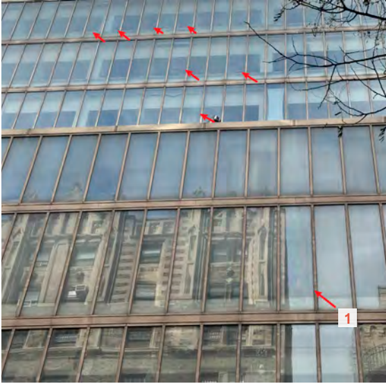
IGU failure
