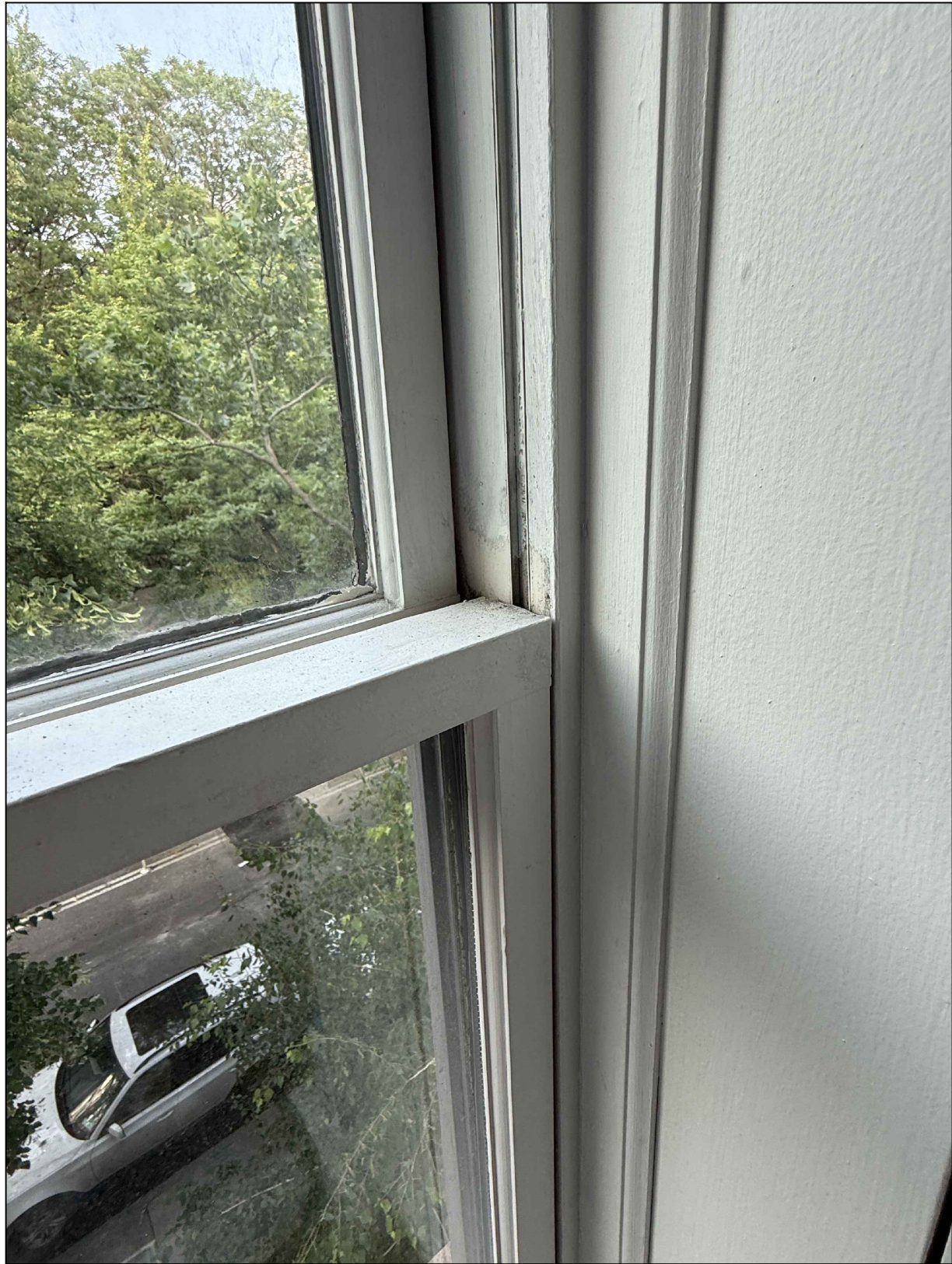
EXISTING WOOD SPIRAL BALANCE DH
