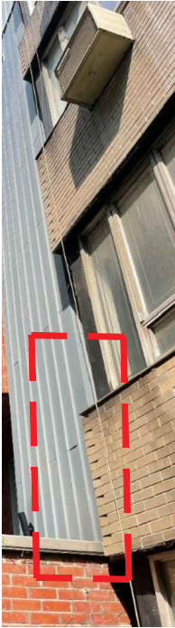
4 LEFT AND RIGTH BRICK CORNER PATTERN DO NOT MATCH LPC-05 Scale: N.T.S.
