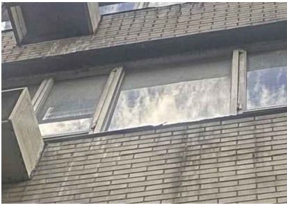
3 METAL SILLS ERODING - TO BE REPLACED LPC-05 Scale: N.T.S.
