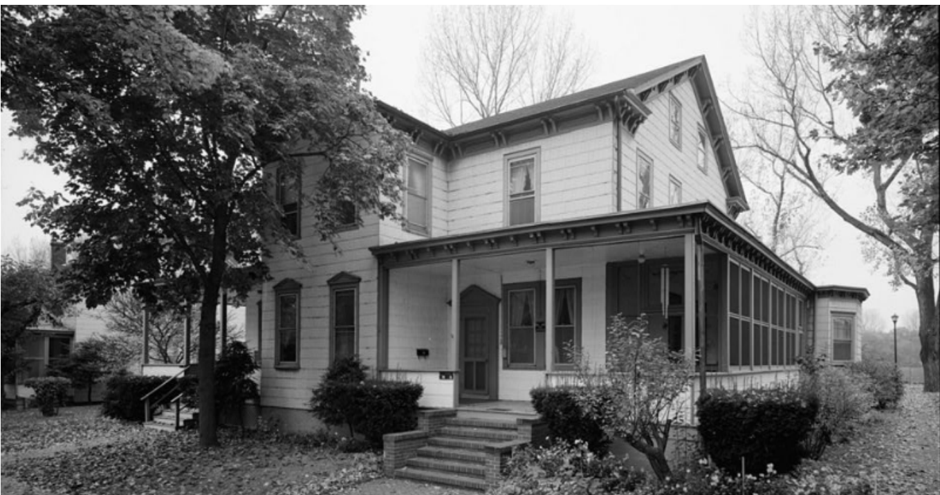
1982 - ASBESTOS SIDING VISIBLE
