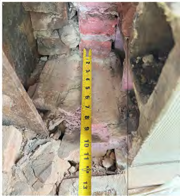
4 MASONRY INFILL AT THE WEB OF THE TERRA COTTA SCALE: N.T.S.
