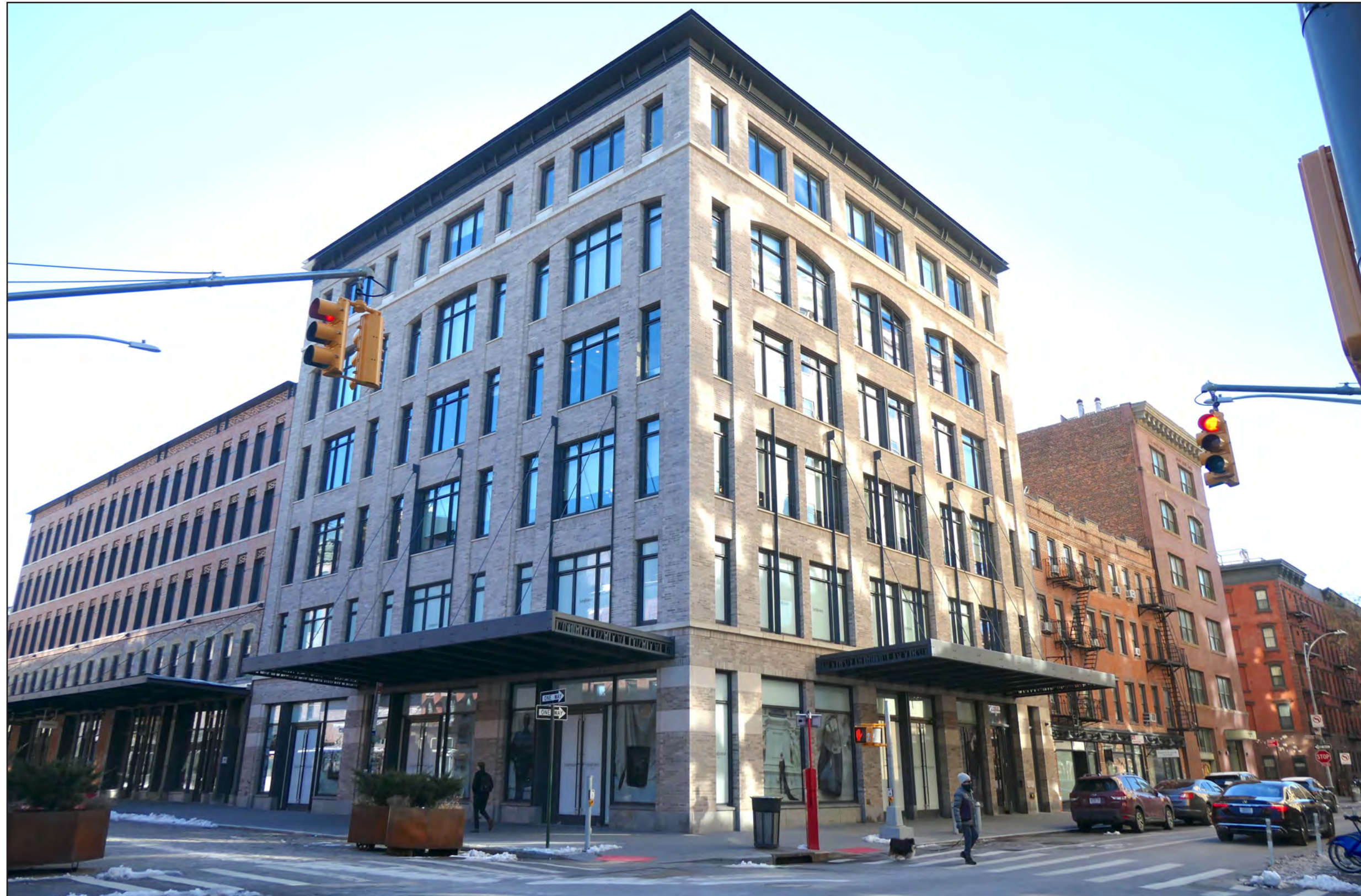
70-74 GANSEVOORT STREET - EXISTING CONDITION
