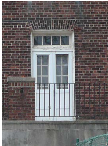
EXISTING TERRACE DOOR
