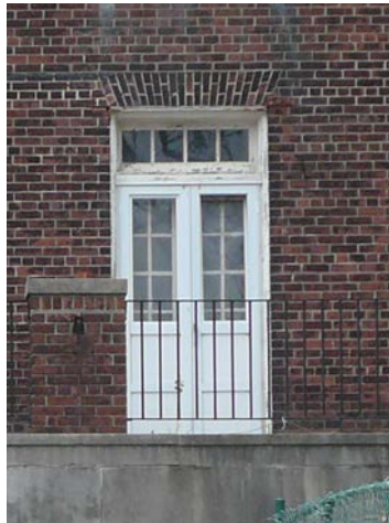
EXISTING TERRACE DOOR
