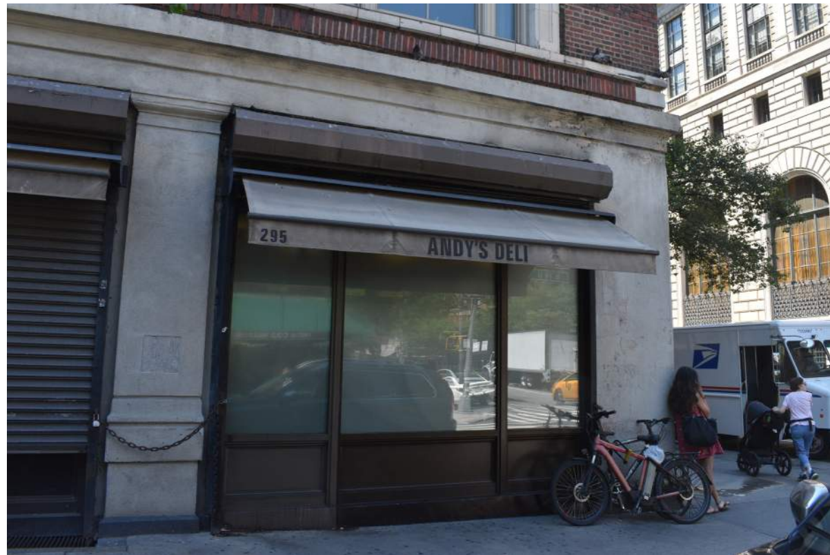
295 Amsterdam Ave.- Stucco Storefront
