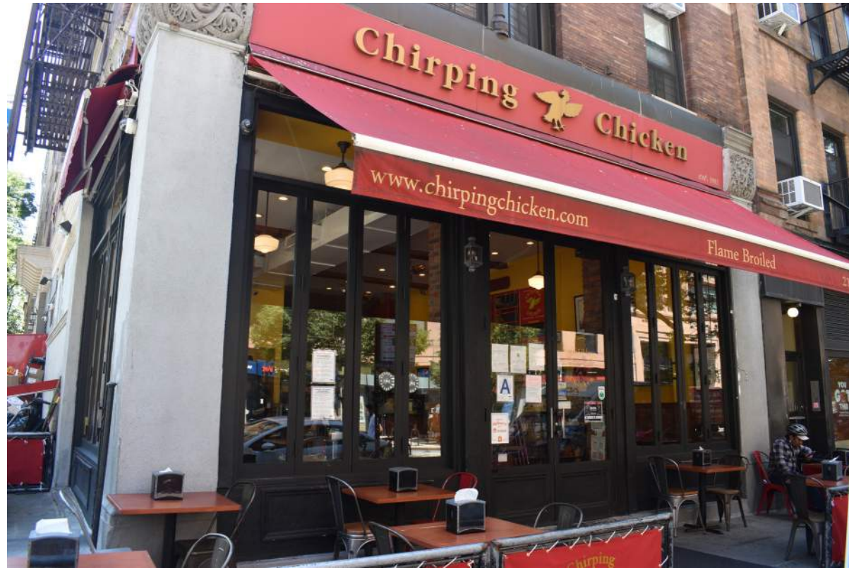
355 Amsterdam Ave. - Stucco Storefront
