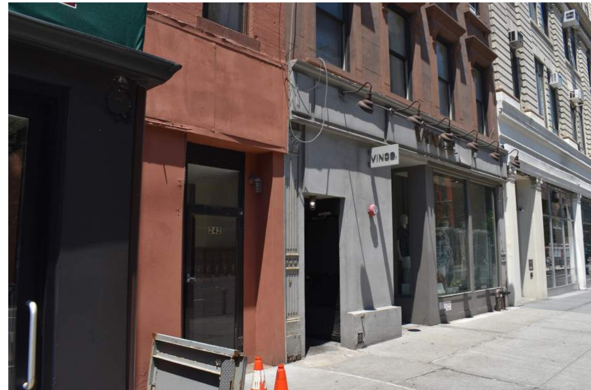
242-244 Columbus Ave. Stucco Storefronts
