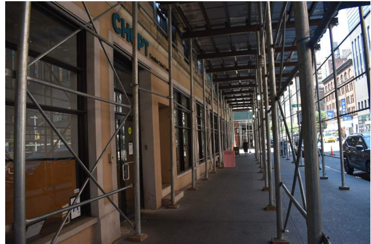
341-343 Amsterdam Ave. - EIFS Storefronts
