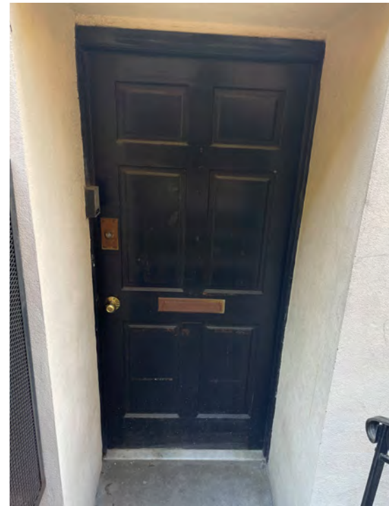
Existing 105 areaway door
