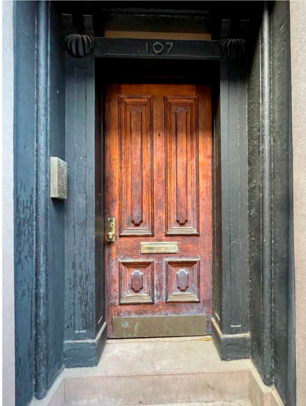
Existing 107 front door
