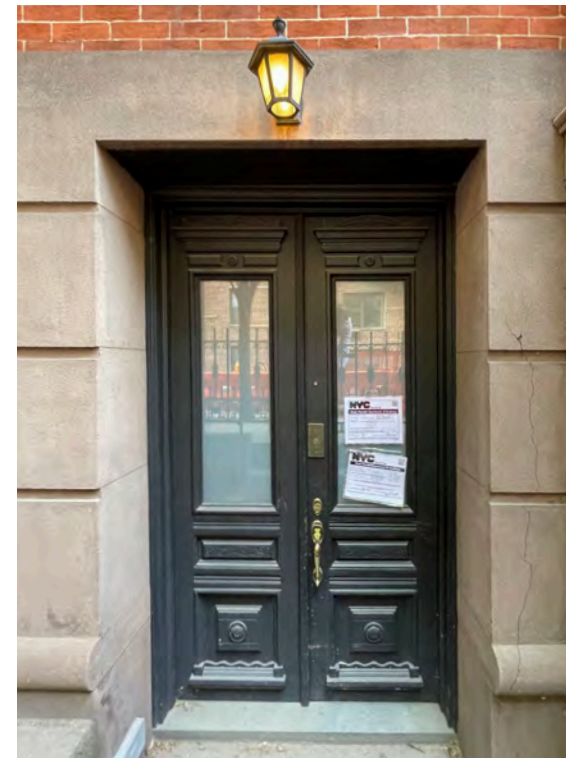
Existing 107 areaway door
