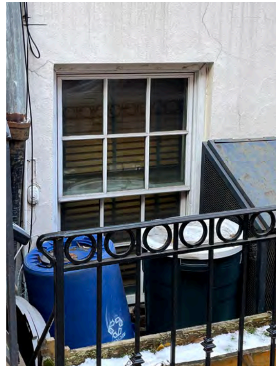
Existing 105 areaway door
