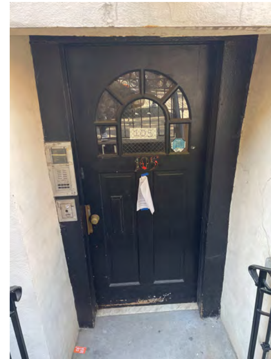
Existing 105 areaway door
