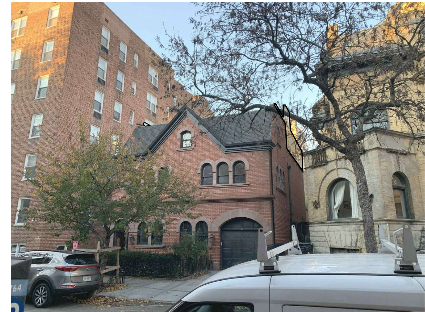
E VISIBILITY PHOTO FROM E (124 JORALEMON) LPC-5 SCALE: N.T.S. (PARAPET & CHIMNEY VISIBLE)
