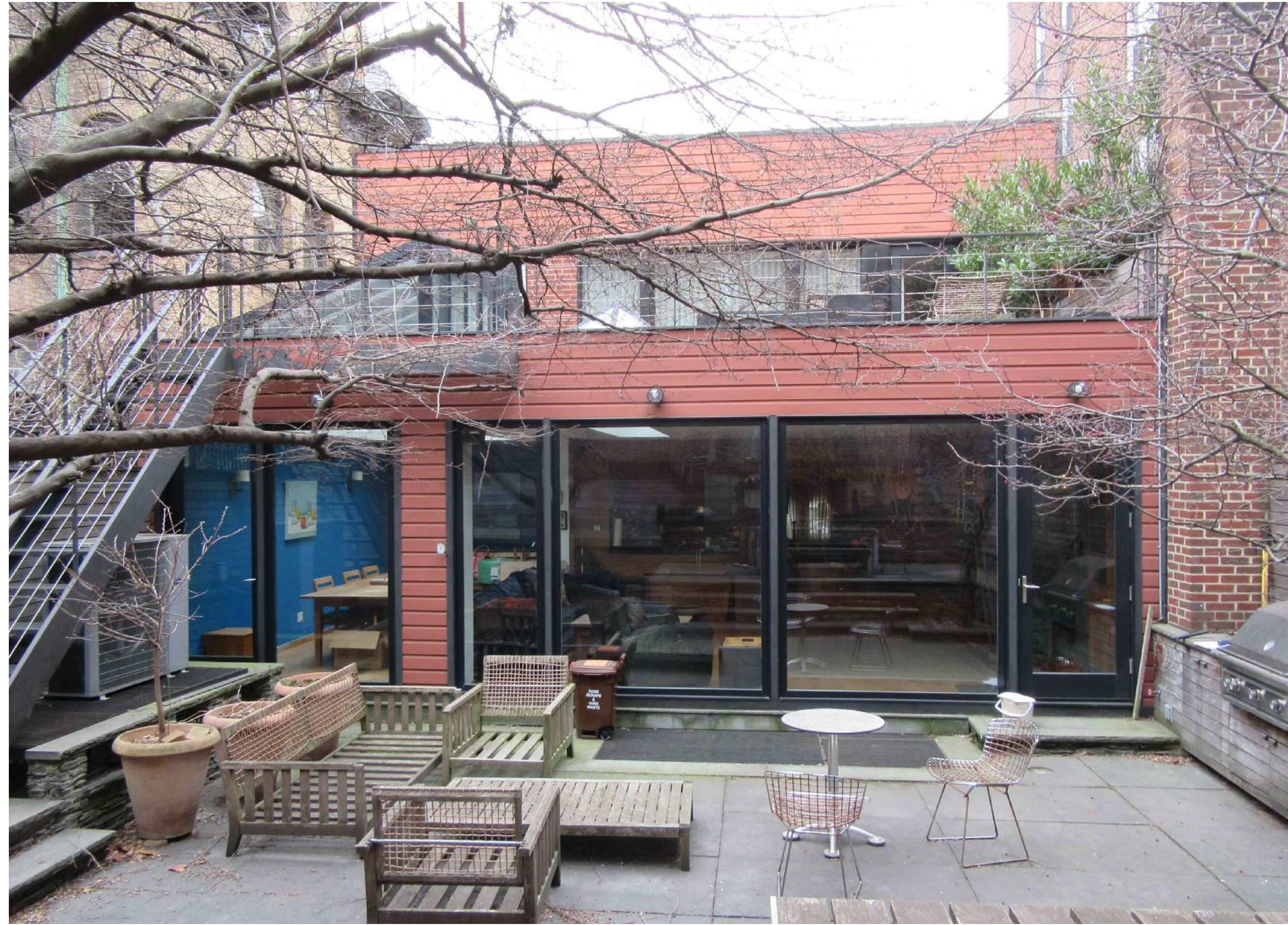
1 EXISTING REAR ELEVATION PHOTO A-204 SCALE: N.T.S.
