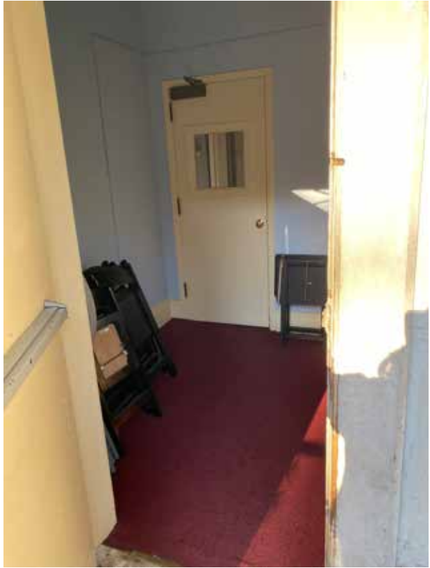
Door to Vestibule 1
