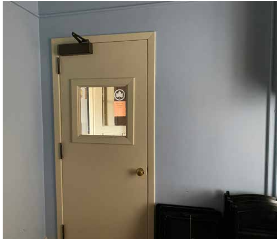
Door to Vestibule 2
