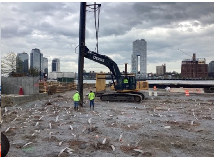
2023年4月，灯芯排水管的安装
