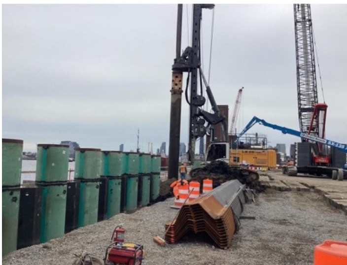
2023年4月，结合墙的施工
