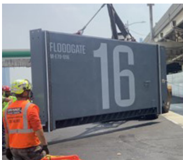
2023年4月和6月，防洪闸门10号，13号，16号和17号安装在项目区域2。
