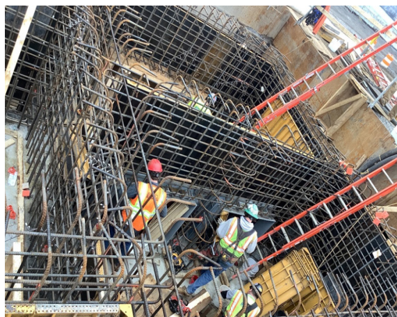
2023年1月,深层下水道的挖掘和施工
