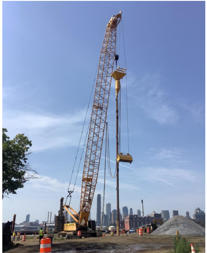
2022年7月东河岸公园滨水区域的土壤稳定工程
