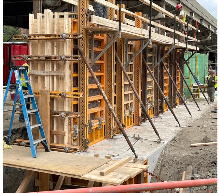
Cimentación y encofrado para la primera sección del muro de contención en el Parque Stuyvesant Cove
