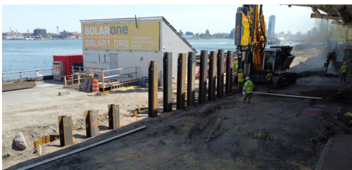
在Solar One 附近的Stuyvesant Cove 公园安装的H桩
