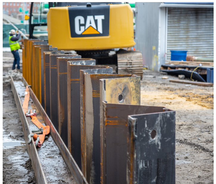
Stuyvesant Cove 公园安装的板型桩
