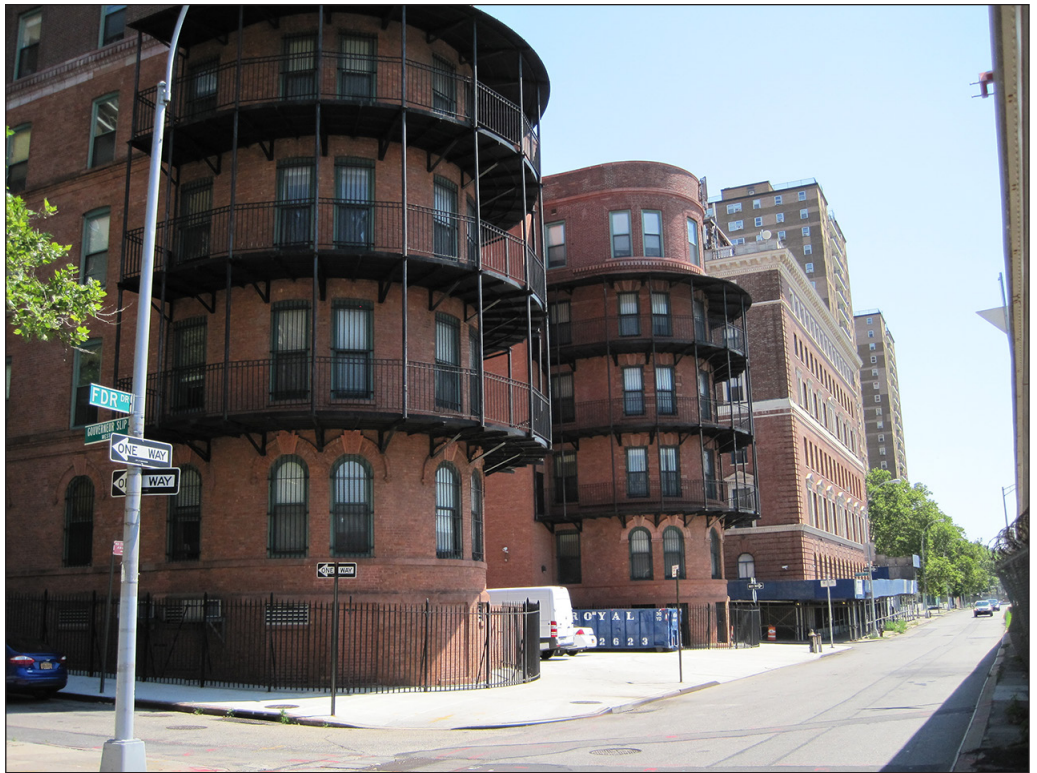
Gouverneur Hospital (#5). South Street façade 9
