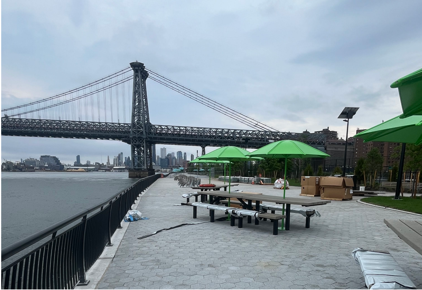
公园设施安装于北侧网球场附近 – 2026年6月
