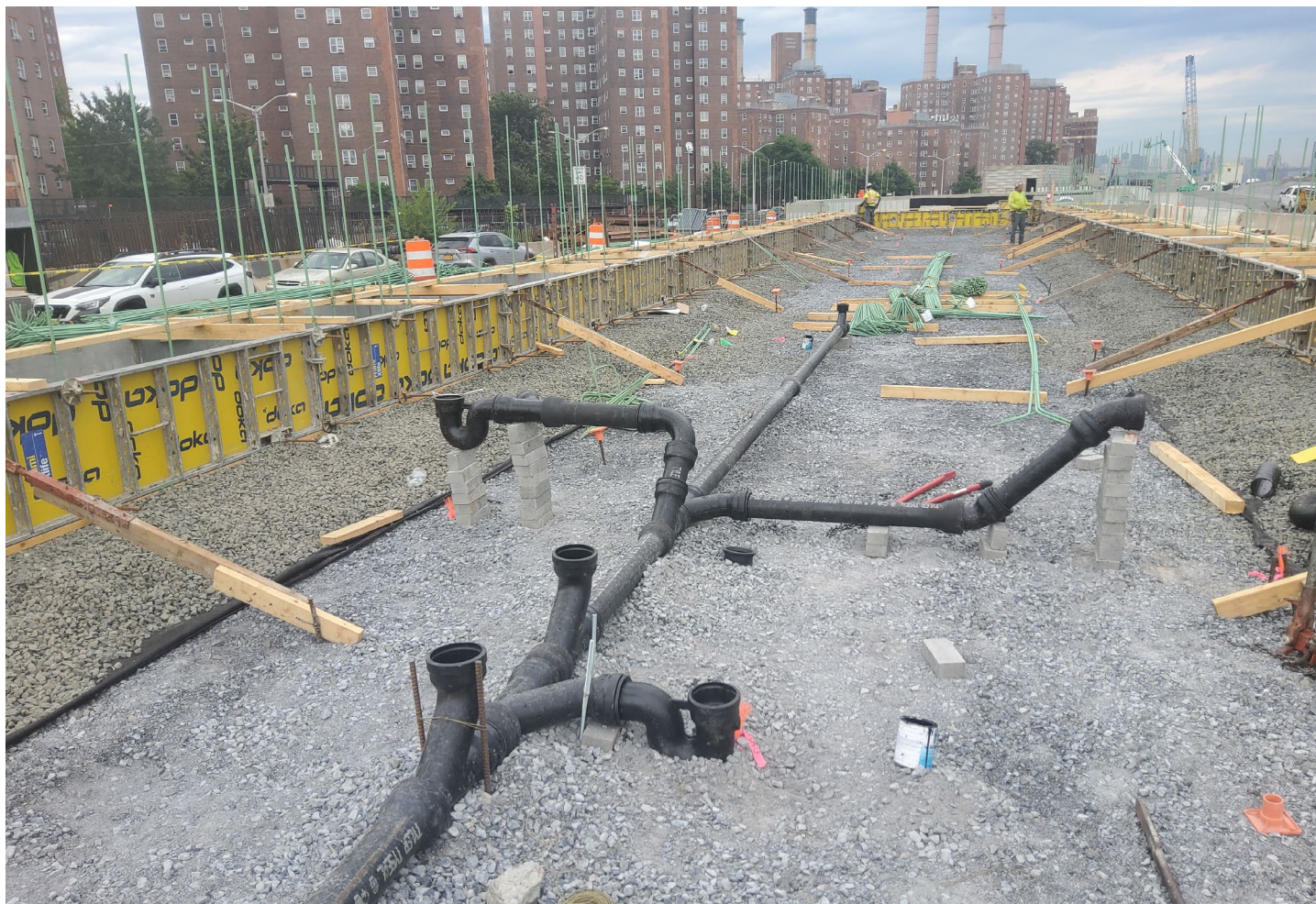
已安装用于未来 track house 的基础模板及管道设施—2026 年6月
