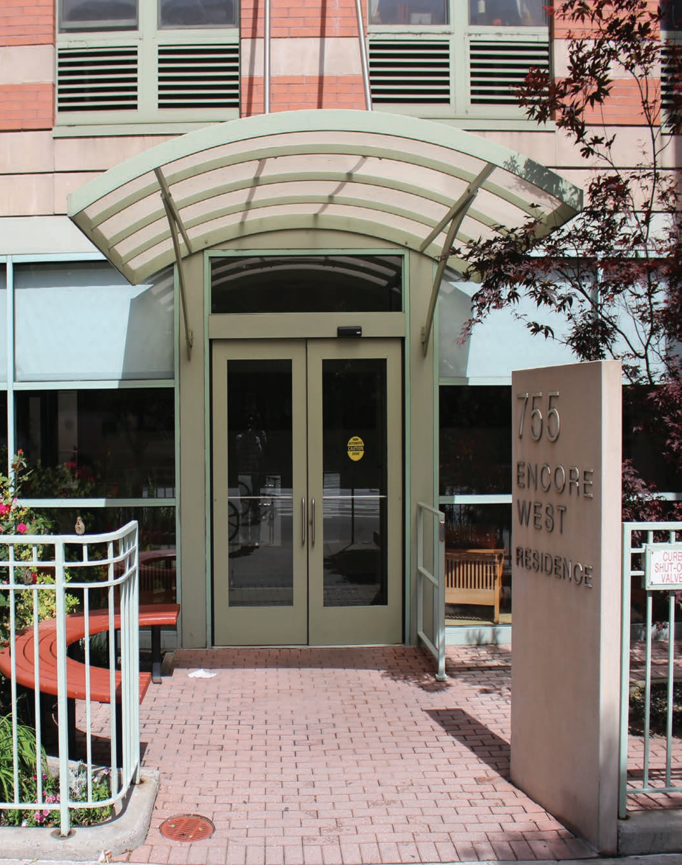
樓宇入口有易於讀取的樓宇標誌；提供座椅；提供架空式陰涼處與防風雨設施；設有自動玻璃門；旁邊安裝扶手；維護良好的寬闊通道；提供植栽。圖片由 Encore Community Services 提供。
