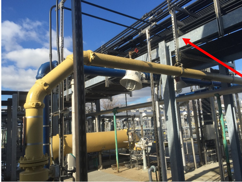
Overhead conduit runs
